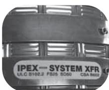
Les accouplements mécaniques MJ Gris se différencient facilement des manchons standards en fonte grise en remarquant que la chemise intérieure en caoutchouc est de couleur grise (et non de la couleur noire habituelle) et en notant la présence des étiquettes d'identification extérieures indiquant la marque Système XFR et les valeurs des indices de propagation de la flamme et de dégagement des fumées selon la norme ULC S102.2.
